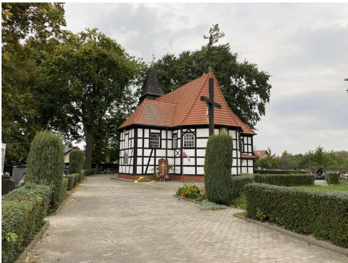
Ryc. 3. Kaczkowo, kościół pw. Św. Marcina. Fot. P. Pawlak
