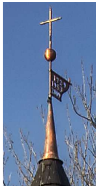
Fot. 39. Szczyt wieży
