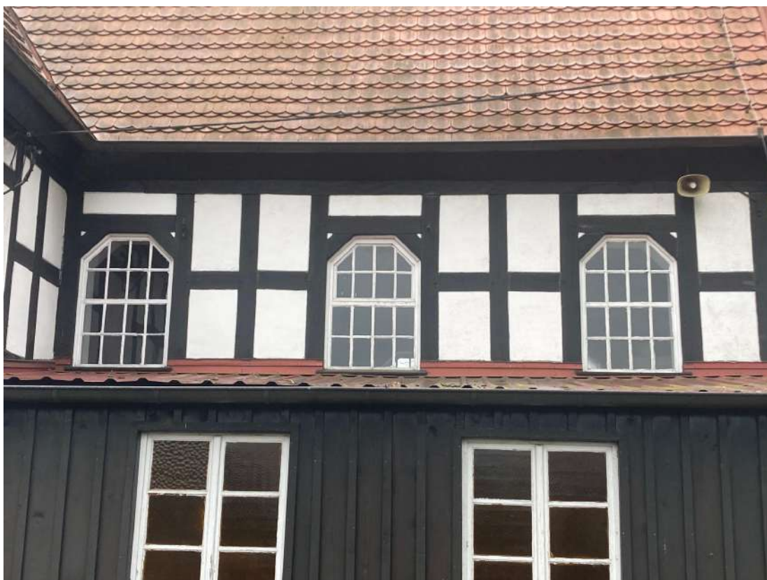
Fot. 19. Dach blaszany nad kostnicą, elewacja północna
