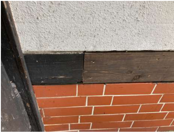
Fot. 1. Podwalina, dodany wtórny element, elewacja wschodnia.
