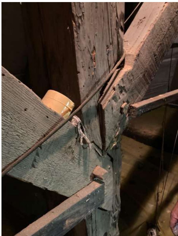
Fot. 28. Łączenie słupów, poddasze
