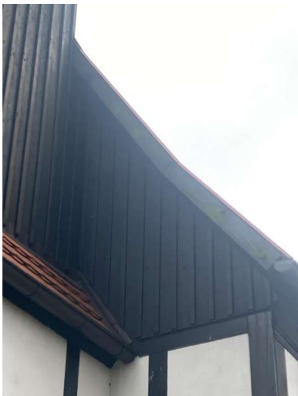
Fot. 40. Okładzina drewniana, detal, elewacja zach. południowa.
