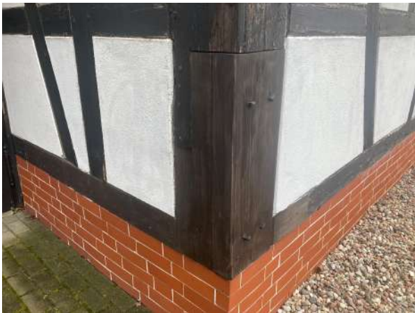
Fot.3. Słup, elewacja wschodnia
