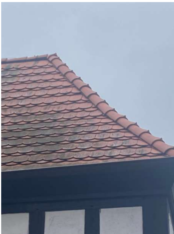
Fot. 21. Detal dachu
