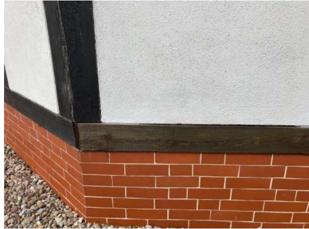
Fot. 2. Podwalina, Podwalina, dodany wtórny
