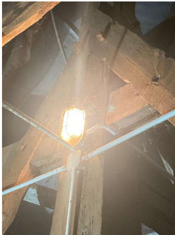
Fot.35. Słup i krokwie, konstrukcja, poddasze
