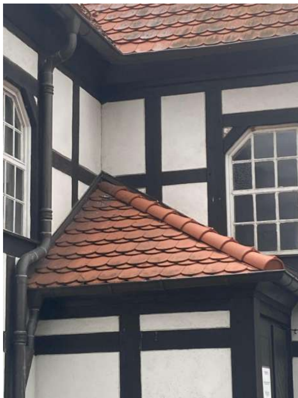
Fot. 11. dach nad przedsionkiem
