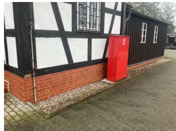
Fot. 6. Podmurówka, elewacja północna
