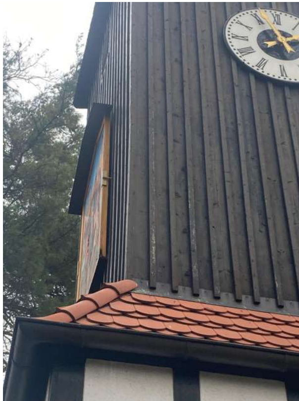
Fot. 41. Okładzina drewniana na wieży, detal, elewacja
