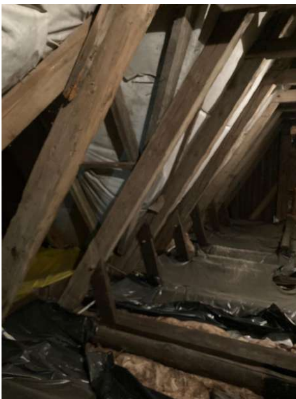
Fot. 27. Konstrukcja dachu, poddasze
