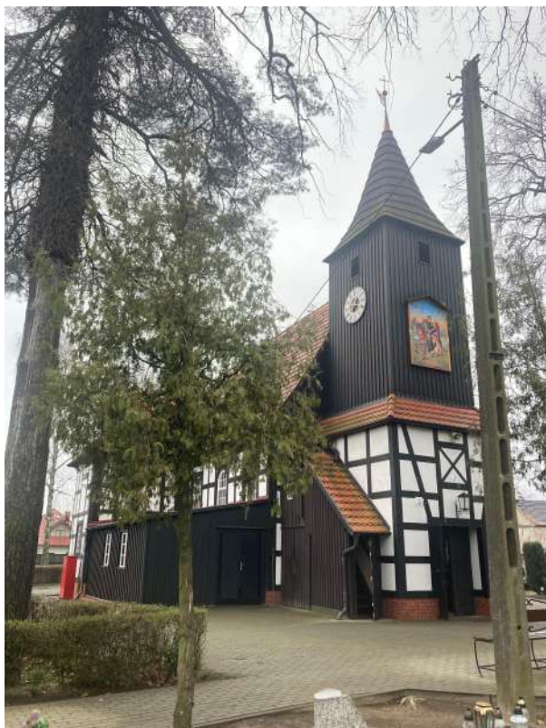
Fot. 36. Elewacja pd-zach, wieża
