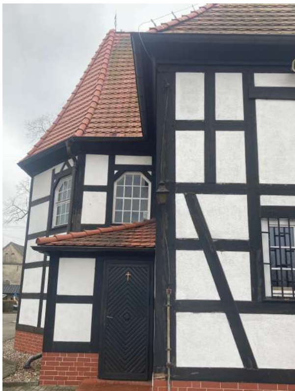
Fot. 24. Widok na prezbiterium, elewacja pn
