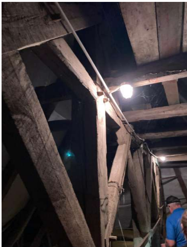
Fot. 26. Konstrukcja dachu, poddasze
