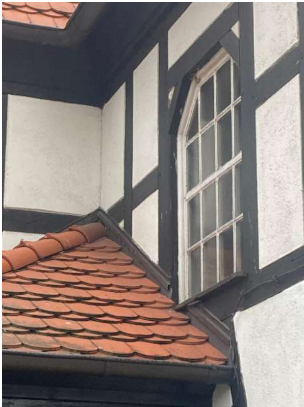
Fot. 45. Stolarka okienna, detal, elewacja wschodnia
