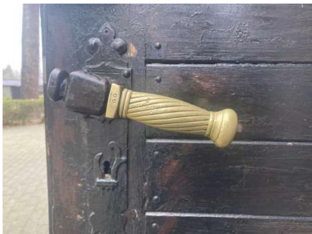
Fot. 46. Klamka, drzwi wejściowe, elewacja zachodnia
