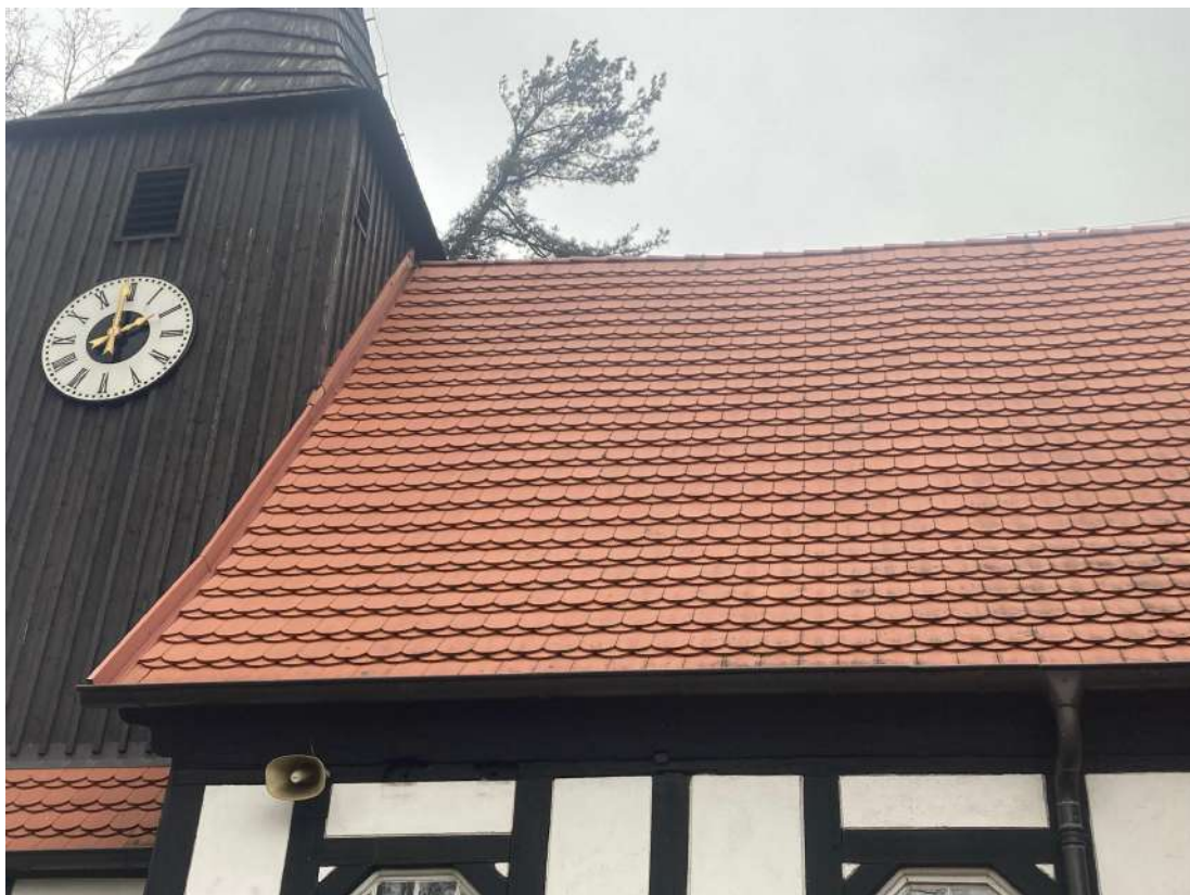
Fot. 18. Dach dwuspadowy, wieża z zegarem, elewacja pd
