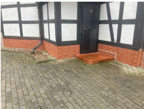
Fot. 5. Podmurówka, elewacja wschodnia
