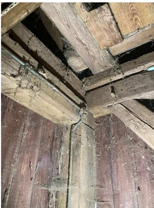
Fot.33. Łączenie słupów i belek, poddasze
