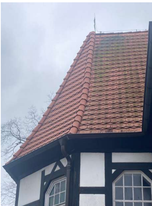
Fot. 25. Dach, prezbiterium, detal
