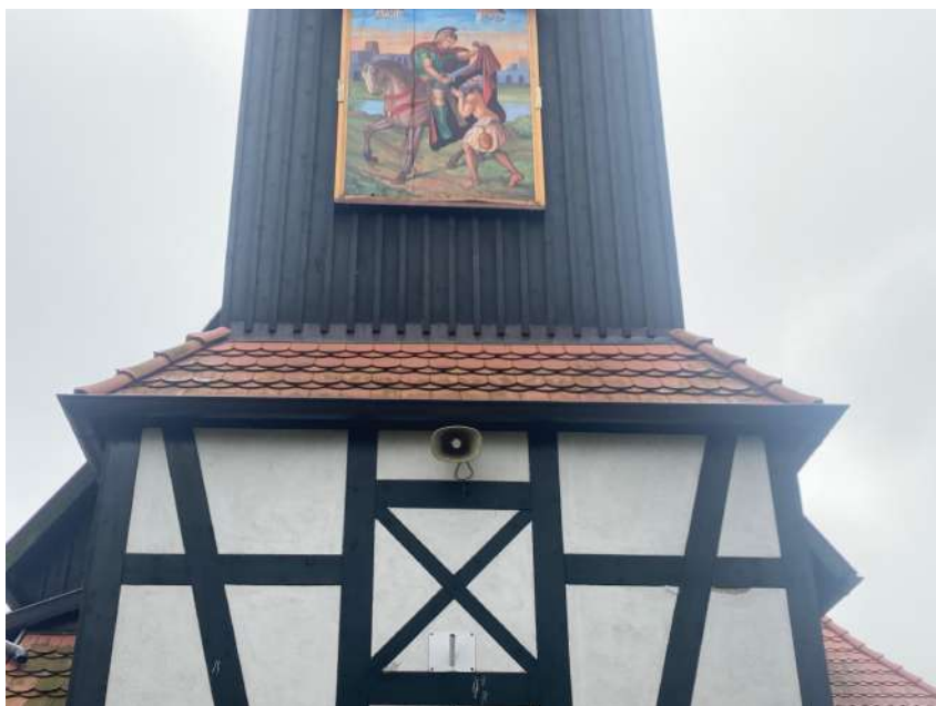
Fot. 38. Detal elewacji zachodniej
