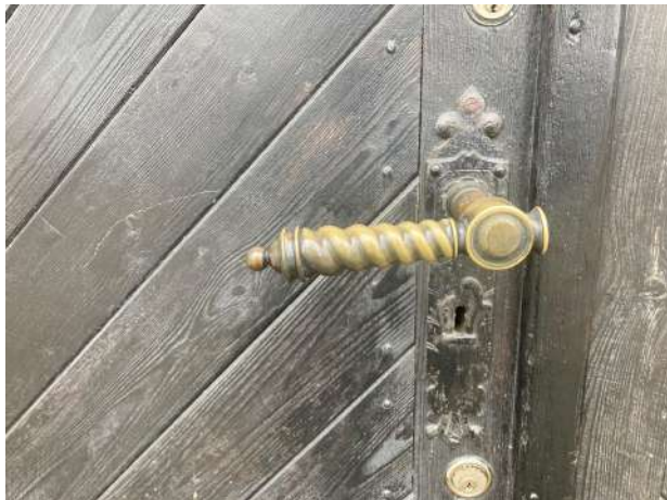
Fot. 48. Klamka, drzwi wejściowe, elewacja zach.
