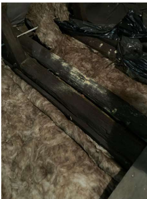
Fot. 29. Belki stropowe, wełna mineralna, poddasze
