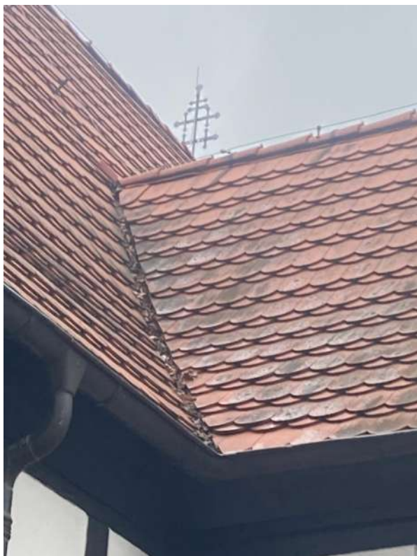
Fot. 20. Detal dachu,
