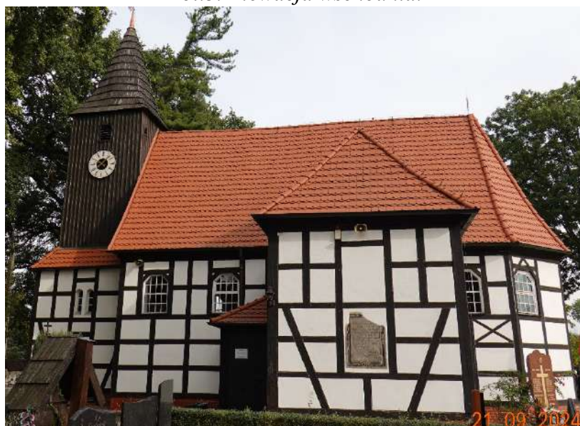
Fot.4. Elewacja południowa.
