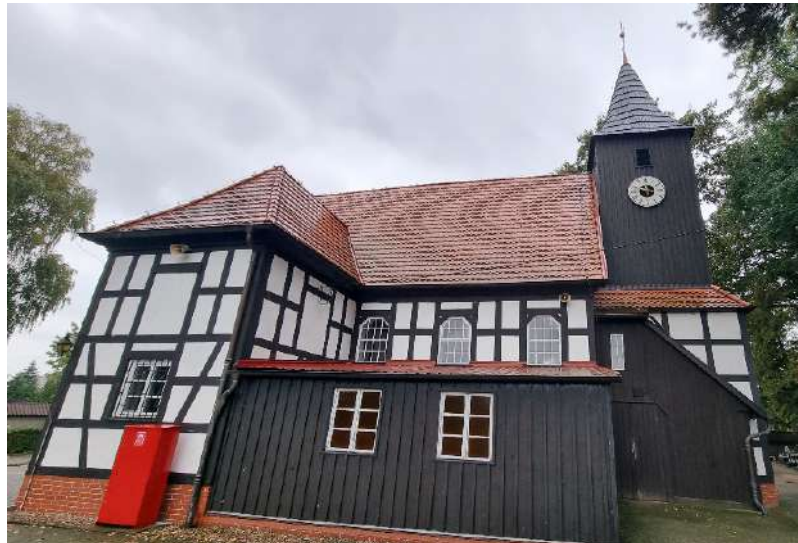
Fot.1. Elewacja północna.
