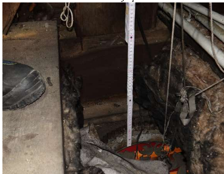
Fot.7. Konstrukcja stropu.
