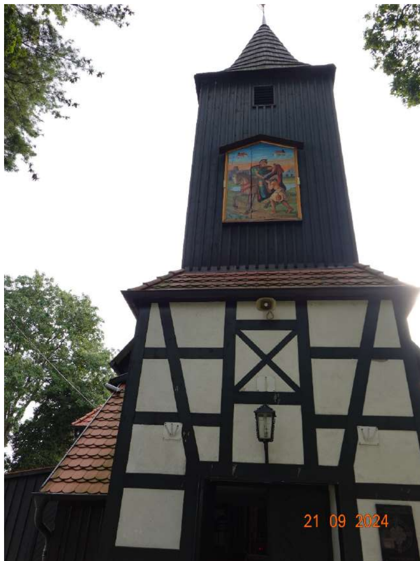
Fot.2. Elewacja zachodnia.
