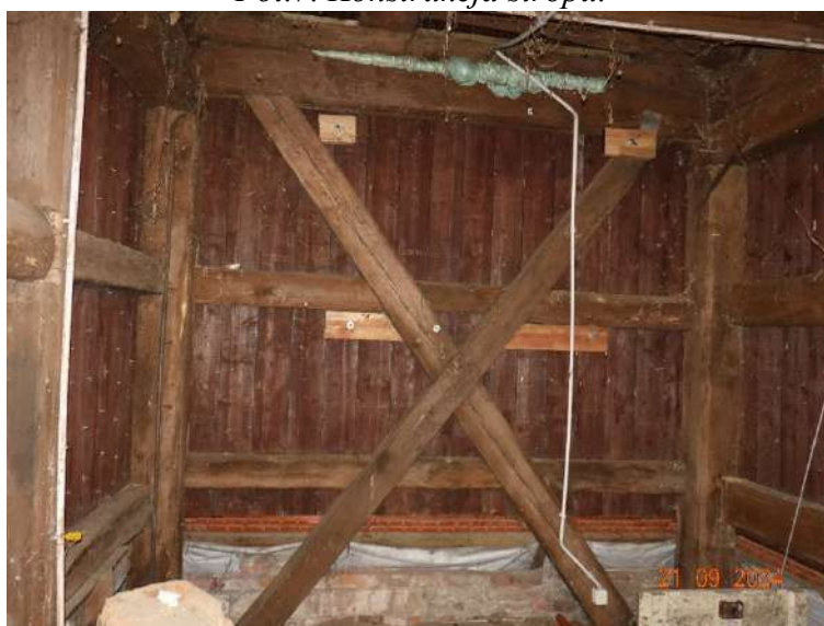
Fot.8. Wnętrze wieży.
