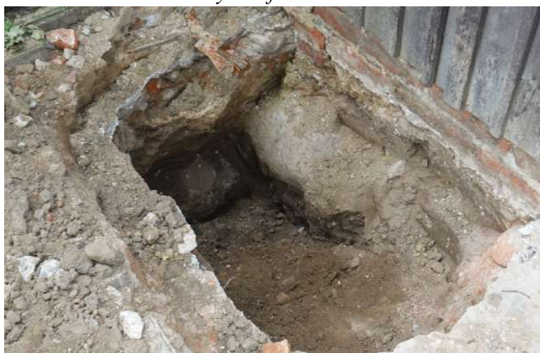
Fot.11. Odkrywka fundamentowa nr 3.
