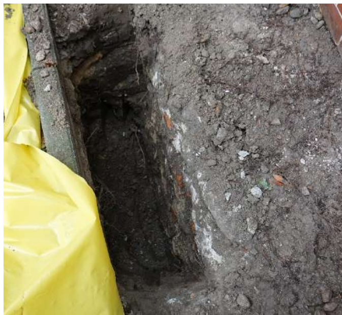
Fot.9. Odkrywka fundamentowa nr 1.
