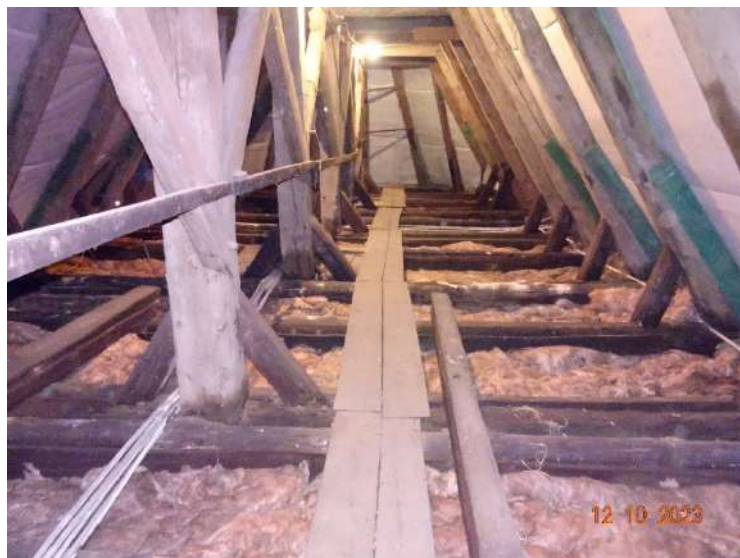
Fot.6. Konstrukcja poddasza.
