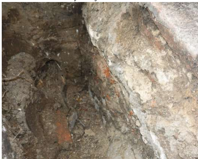
Fot.10. Odkrywka fundamentowa nr 2.
